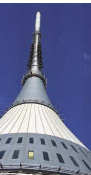
Instalace na Ještědu
